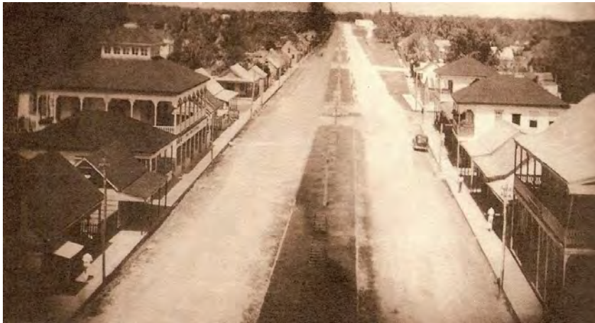
Vista panorámica de la calle Héroes antes del Huracán Janet. .(BAUTISTA 2004)
