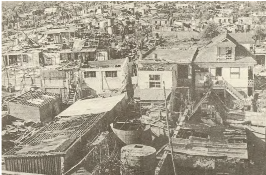
La combinación en los procesos constructivos entre mampostería y madera y la protección del Palacio de Gobierno contra los vientos del sur, permitió a tres casas contiguas en la calle 22 de Marzo permanecer en pie hasta la tercera fase del huracán. .(BAUTISTA 2004)
