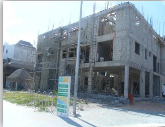
Foto 21. Construcción de hotel Fuente: Propio autor
