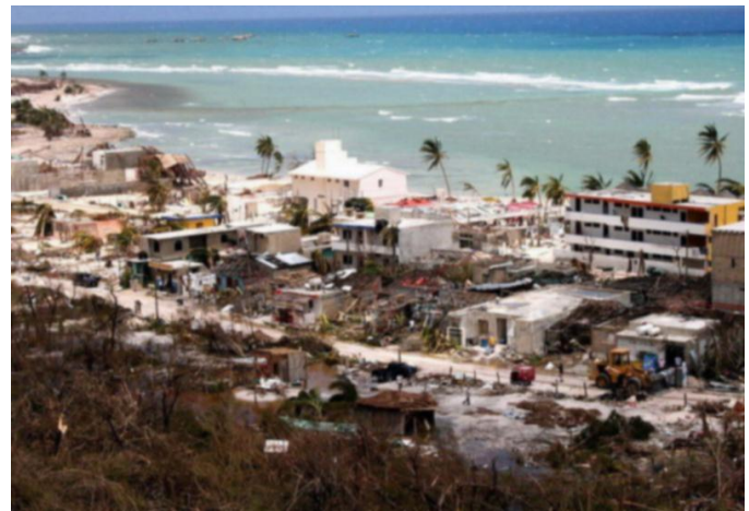
Foto 3. Daños en Mahahual por el huracán Dean Fuente: Noticaribe.
