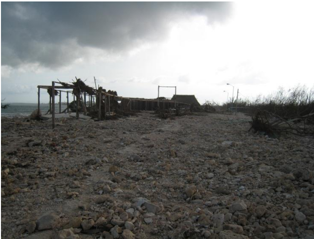
Foto 2. Daños en Mahahual por el huracán Dean Fuente: Sistema de Información Geográfica de la Universidad de Quintana Roo.
