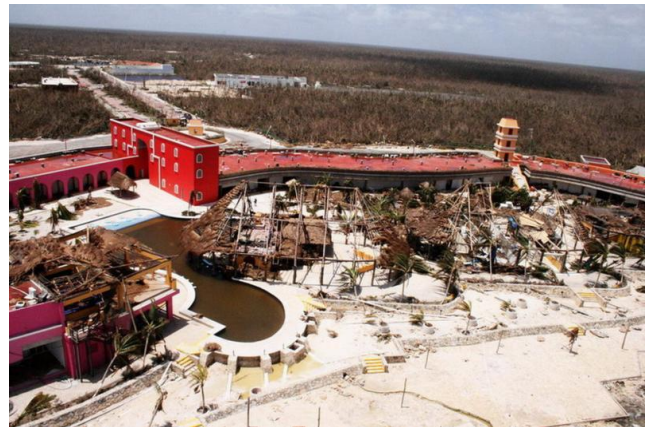
Foto 5. Infraestructura hotelera después del huracán Dean Fuente: Noticaribe.
