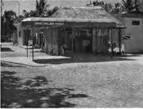
Imagen 21. Terminal de ADO
