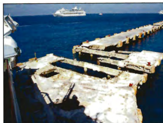
Figura 14. Infraestructura carretera y de comunicaciones (muelle de puerta maya y turístico después del huracán Wilma, 2005 en la isla de Cozumel, Quintana Roo, México.
