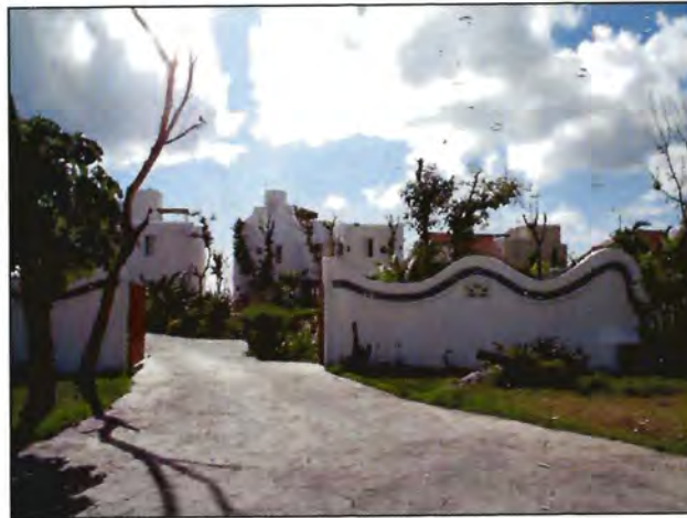
Figura 10. Lote de la carretera costera sur de la isla de Cozumel, señalando varias casas particulares en una sola área.
