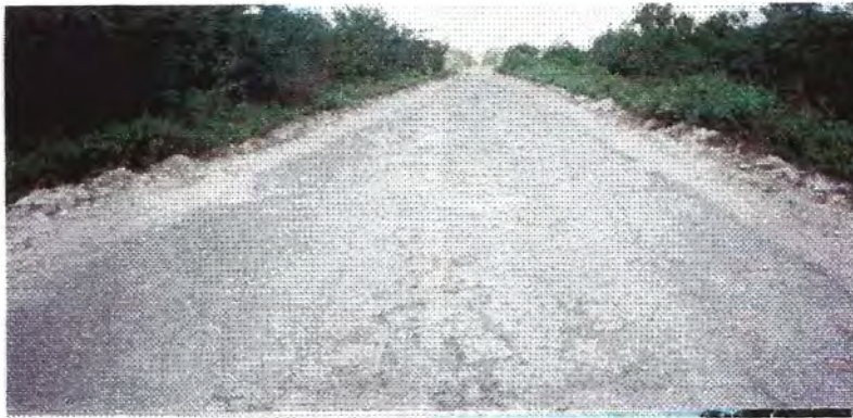
Cuadro No. 23. Carretera Cafetal-Mahahual segundo tramo. Se encuentra en reparación. Fuente: Ibídem.
