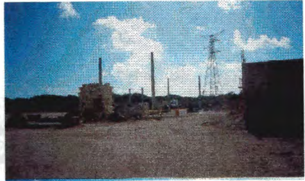
Subestación Eléctrica en Mahahual
