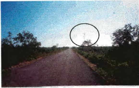
Carretera Cafetal-Mahahual. Tendido Eléctrico.
