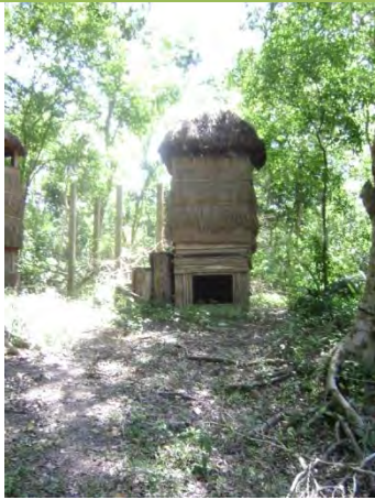
Foto 13.- Baños Ecológicos contruidos en la zona del mirador.
