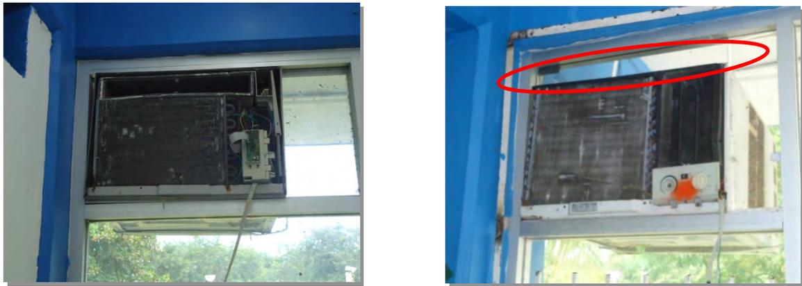
**Figura 4.1** Aires acondicionados con falta de mantenimiento y con mala instalación.
