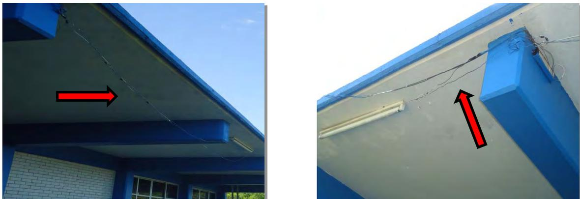
**Figura 4.9** Conductores a la intemperie sin protección alguna.
