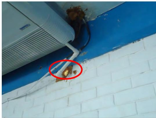
**Figura 4.2** Orificio mal sellado en donde se encuentra la tubería de desagüe del equipo acondicionador.
