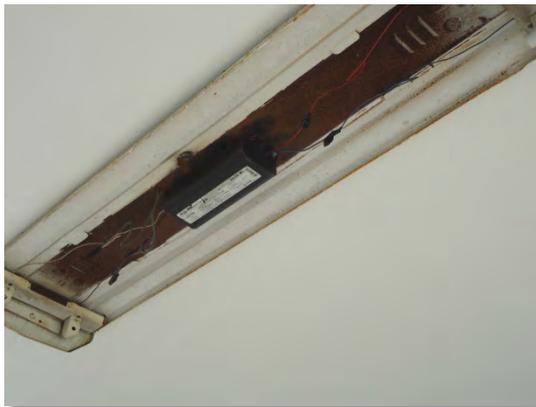
**Figura 4.5** Bases sin lámparas y con exceso de óxido y polvo
