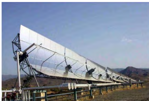
Figura11. Colector solar de media concentración con seguimiento de un eje (Maldonado 2000).
