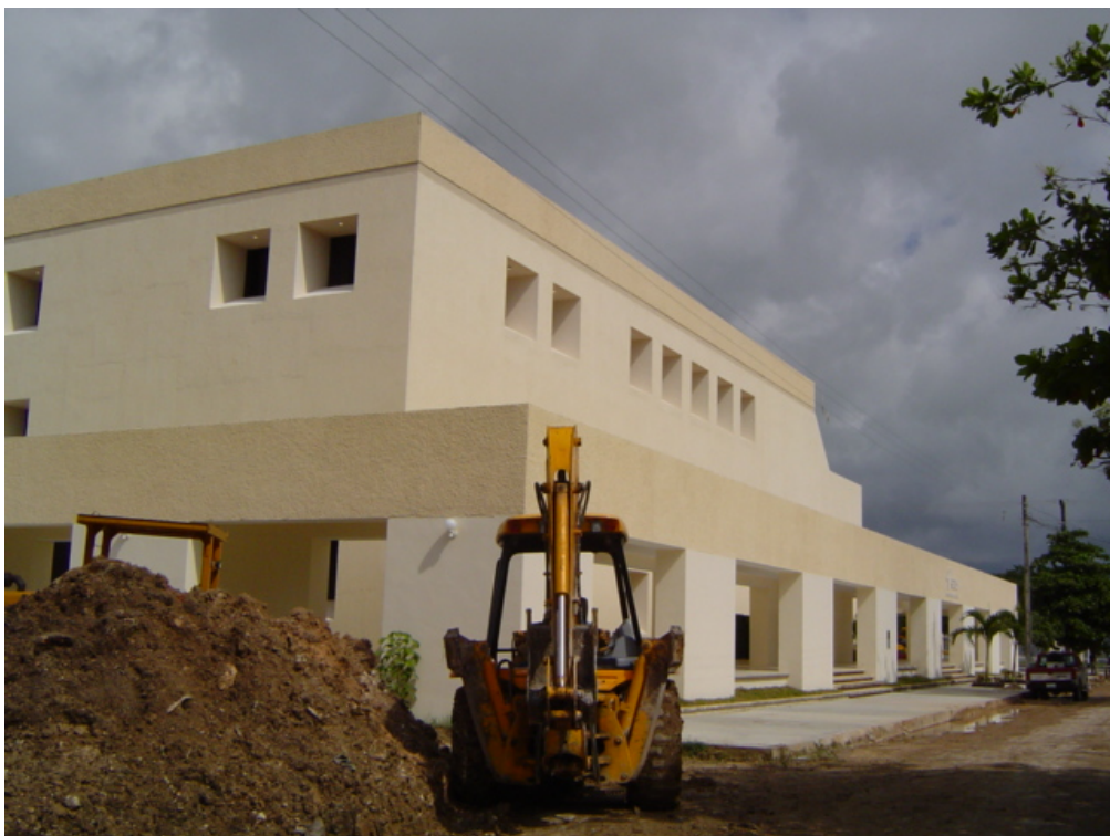
Figura 3.3. Edificio Centro SCT, fachada este.
