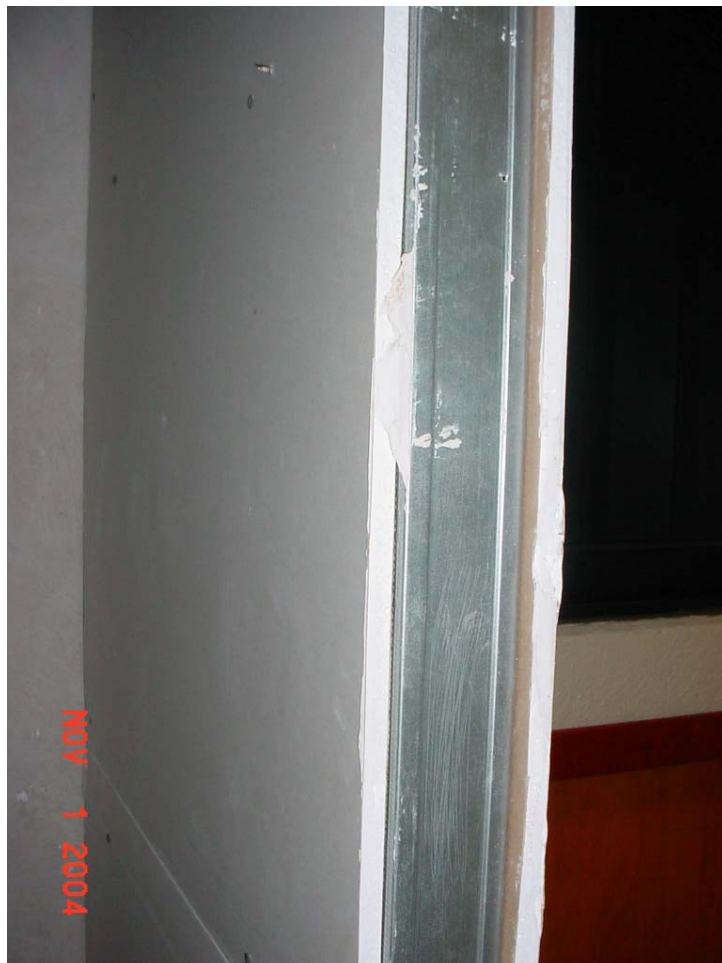
Foto 4. Muro Interior de Tabla Roca (Yeso-Aire-Yeso)
