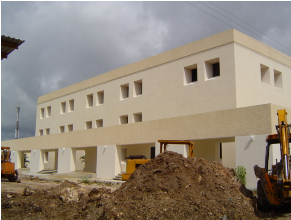
Figura 3.2. Edificio Centro SCT, fachada sur.
