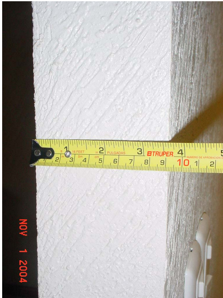
Foto 5. Espesor de Muro Interior de Tabla Roca.
