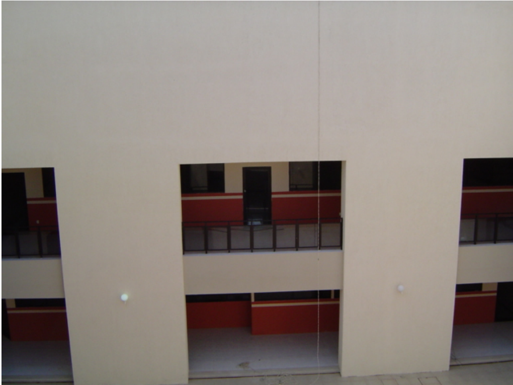
Foto 9. Vista de Paredes Interiores.
