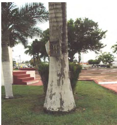
Figura 2.2 Interruptor colocado en el tronco de una palmera.
