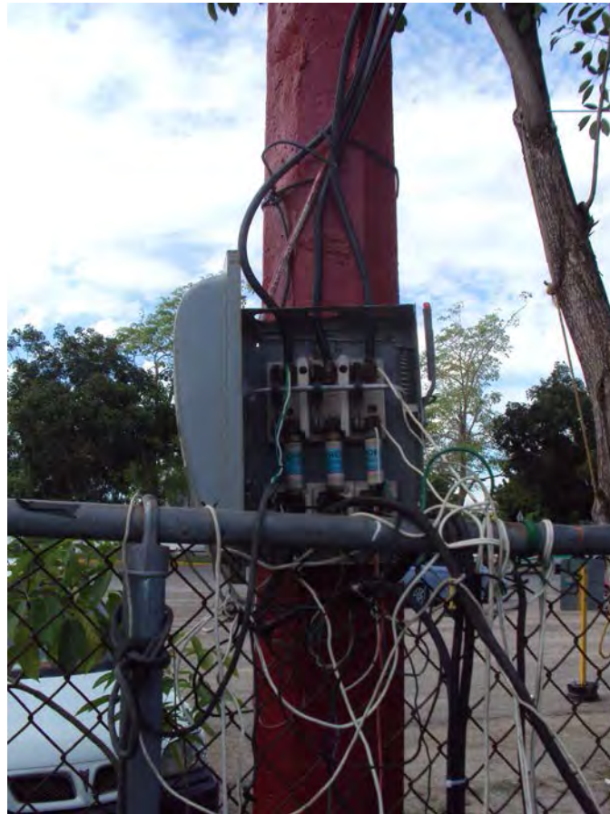
Figura 3.2 Gabinete principal ubicado cerca del acceso a la Expofer
