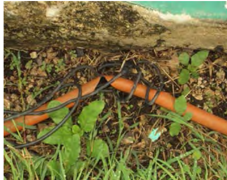
Figura 1.1 Anomalías detectadas en conductores y tuberías.
