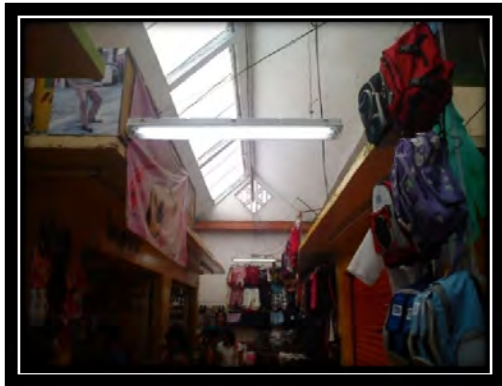
Fig. 3. Techo remodelado en el área de la venta de ropa con láminas de policarbonato.
