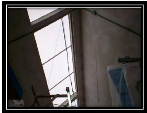
Fig. 4. Techo remodelado en el área de la venta de ropa con láminas de policarbonato.
